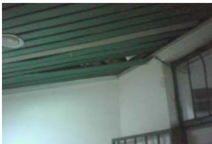
شکل ۲: تخریب سقف کاذب و فرو ریختن آب
